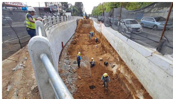
Gráfica no 5. Excavación Paso a desnivel Bulevar Vista Hermosa y 21 avenida zona 15
