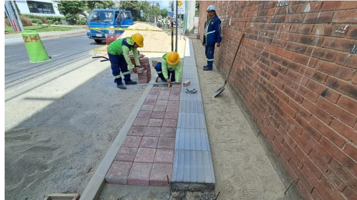
Gráfica no 4. Inicio de obras, Glorieta 9 avenida y 14 calle zona 14
