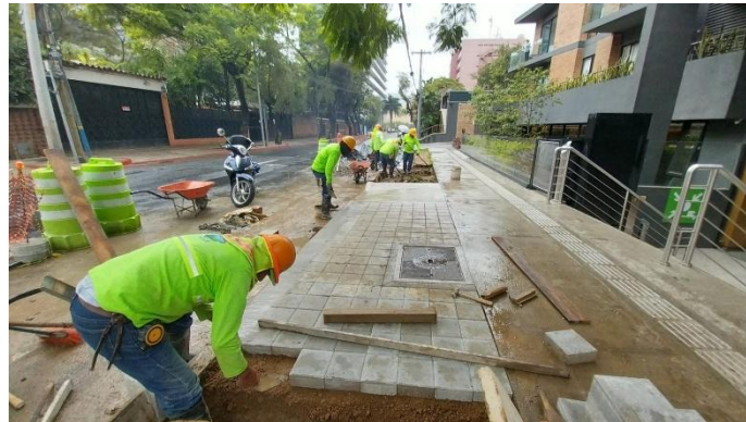
Gráfica no 7. Trabajos Mejoramiento urbano peatonal 13 calle zona 10
