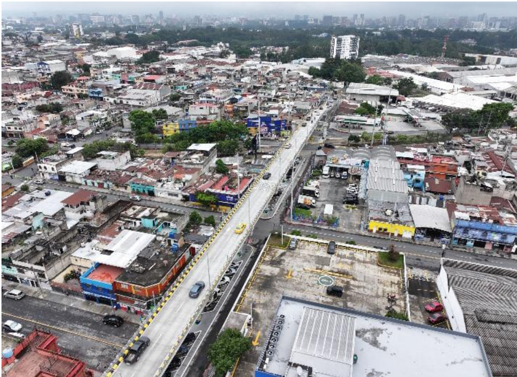
Imagen no 2. Paso a desnivel Atanasio Tzul y 13 calle zona 12
