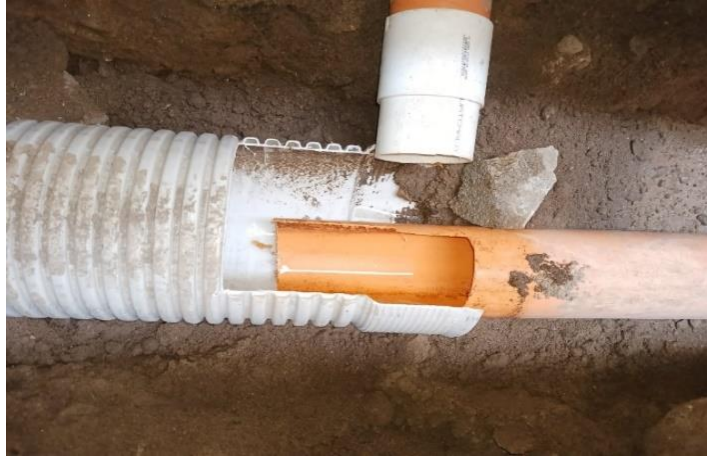
Fuente: Dirección de Alcantarillado y Saneamiento, octubre 2024.
