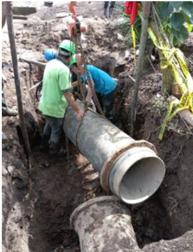
Fotografía 15 Trabajos de interconexión en línea TP3.
