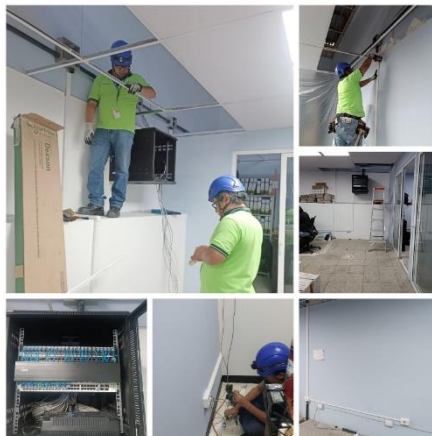
Fotografía 45 Remodelación Dirección de Servicios Básicos
