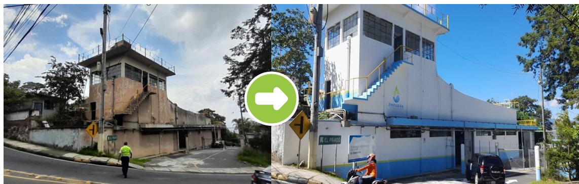
Fotografía 47 Antes y Después de Planta El Cambray, zona 10
