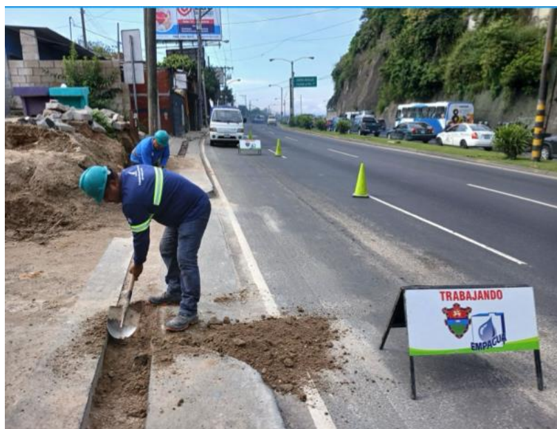
Fotografía 25 Fundición de banquetas en Km. 5.5. Carretera al Atlántico
