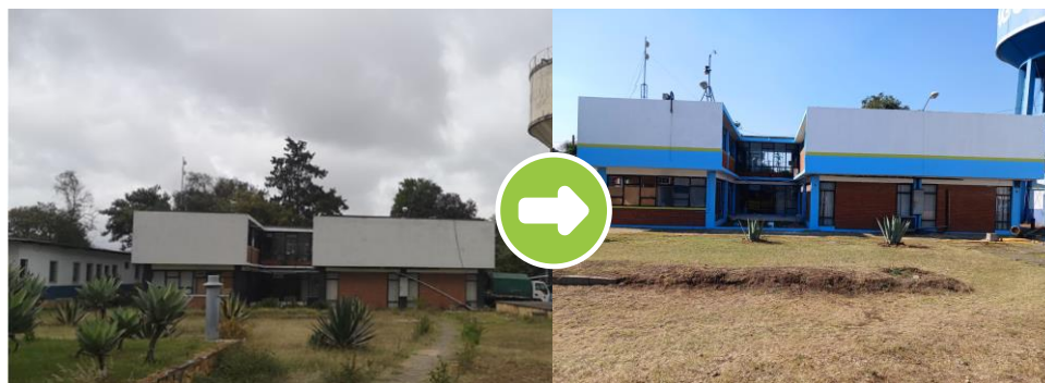
Fotografía 48 Antes y Después de Tanque El Guarda, zona 8
