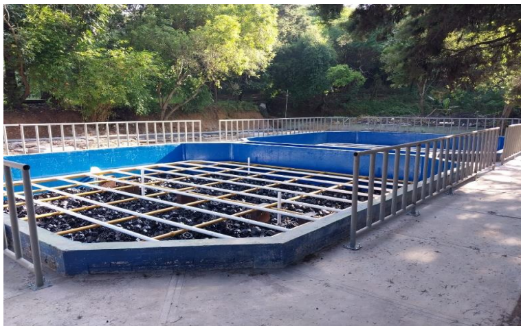
Fuente: Dirección de Alcantarillado y Saneamiento, octubre 2024.
