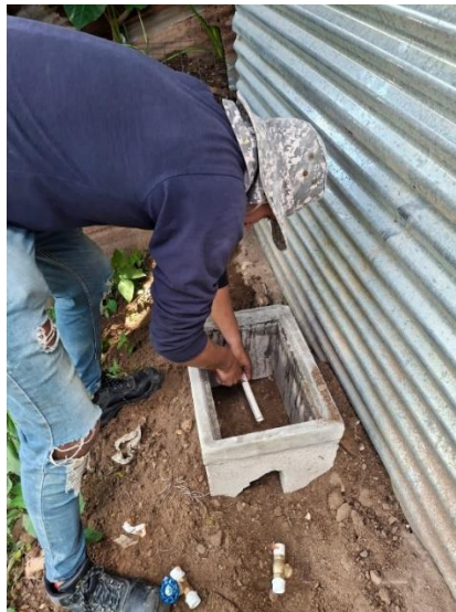
Fotografía 7 Construcción de acometida domiciliar en zona 6.
