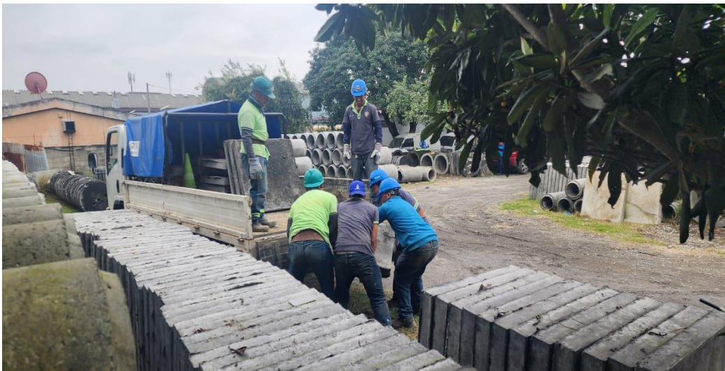
Fotografía 18 Despacho de elementos de concreto
