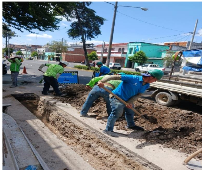
Fotografía 20 Construcción de Alcantarillado Domiciliar
