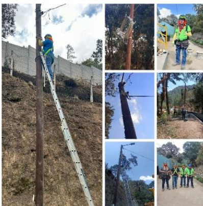
Fotografía 46 Instalación de cámaras de seguridad en Planta El Tesoro
