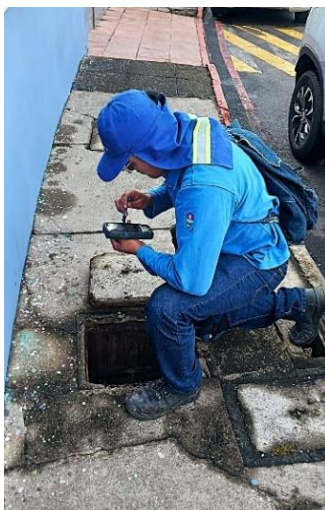
Fotografía 24 Lector realizando Toma de Lectura.
