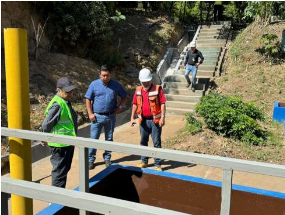
Visita CODEDE noviembre – Planta de tratamientos Bello Horizonte, zona 21
